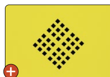
➕ Aération par perforations en partie haute et basse sur les portes
